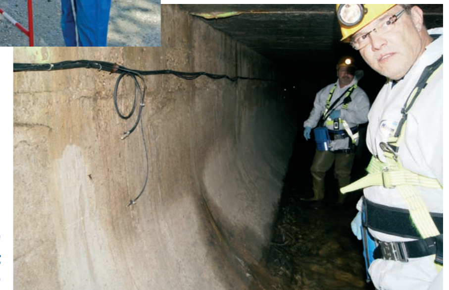
Entraînement à l'intervention en réseau d'assainissement pendant une formation
